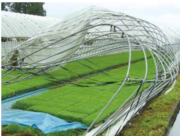
強風でパイプが押し潰された水稻育苗ハウス (令和6年5月・仙北市)
