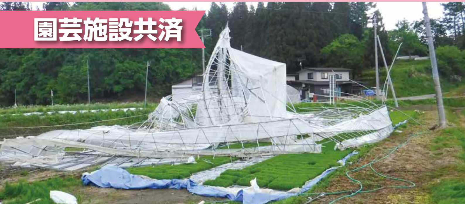
突風によりパイプが根本から持ち上げられた水稻育苗ハウス (令和6年5月・羽後町)
