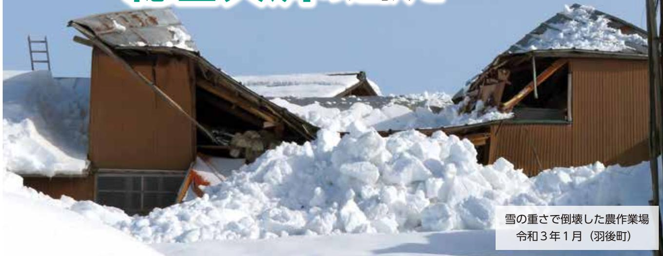
雪の重さで倒壊した農作業場
